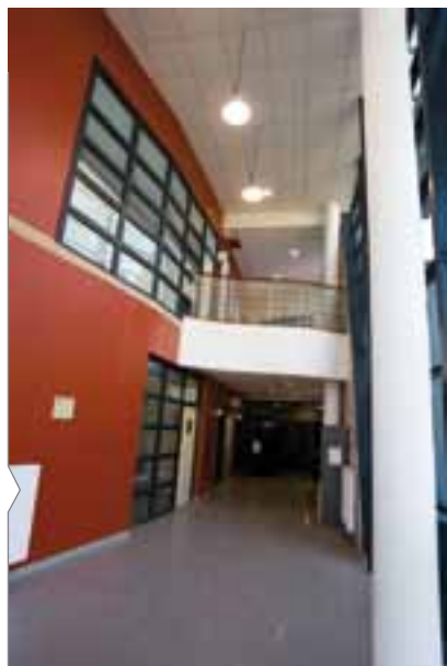
A Saint-Quentin, le collège Jean Moulin a été réhabilité.
