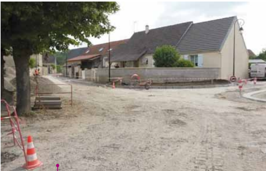
TRAVAUX À OSLY-COURTIL
