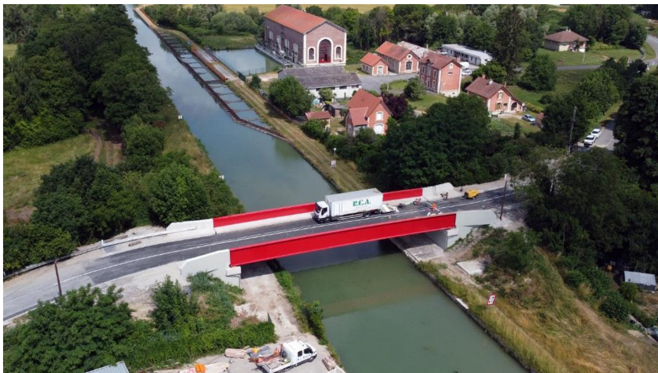
Le nouvel ouvrage d'art n°D0493 RD967 franchissant le canal de l'Oise à l'Aisne (commune de Bourg-et-Comin) après travaux
