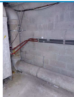
D.O. n° 14 sur Conduit(s) de fluide Fibres- ciment / B
