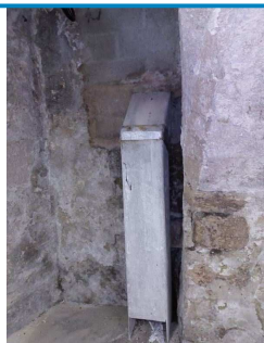
D.O. n° 12 sur Gaine Fibres-ciment / C
