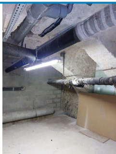
PRLV n° 1 sur Conduit(s) de fluide Métal Calorifugeage laine de verre et feuille cartonnée
