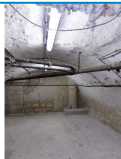
ZH sur D.O. n° 7 sur Plafond Conduits métalliques Calorifugeage laine de verre entoilée
