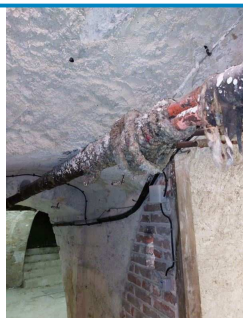
ZH sur D.O. n° 7 sur Plafond Conduits métalliques Calorifugeage bourre laineuse entoilée
