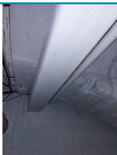
D.O. n° 16 sur Gaine Fibres-ciment
